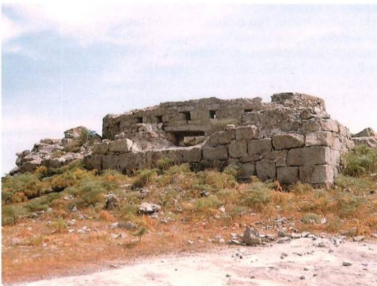
No se conservan más de cuatro hiladas del sillarejo de granito en que está construido el torreón.
