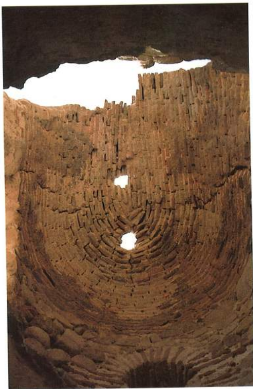
Bóveda de borno de la torre occidental.
